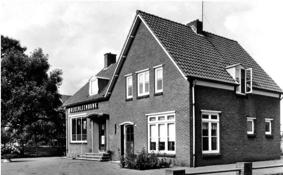
De in 1957 gebouwde Boerenleenbank met kassierswoning. Dit pand werd in 1973 postkantoor, sinds 2001 is slagerij Kees van der Velden er gevestigd. In 1972 fuseerden Boerenleen- en Raiffeisenbank tot Rabobank. Een jaar later verrees een nieuw bankgebouw aan de Heerbaan tegenover het gemeentehuis. Foto: collectie Erik Janssen.
