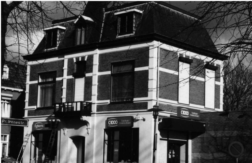
De C1000 aan de Heerbaan in het pand van Gert de Kleijn
