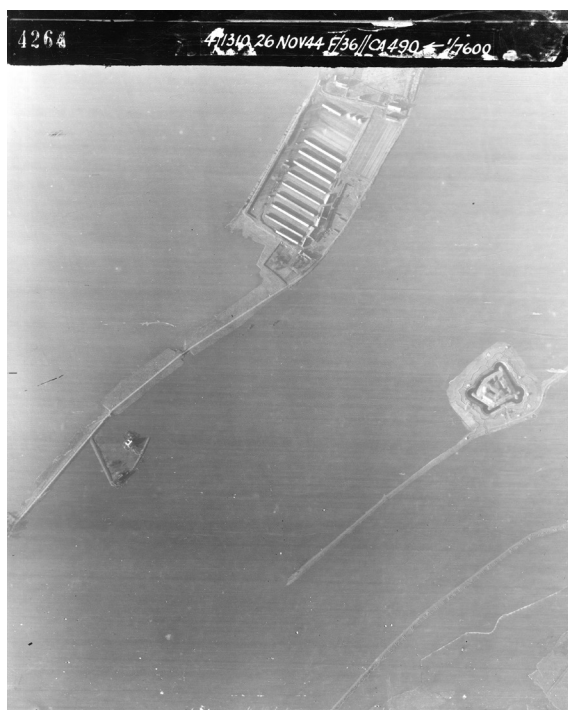
6. Luchtfoto van 26 november 1944. De waterstand van de rivier is hoog. Er staat alleen water in het buitendijkse gebied. Er liggen Duitse loopgraven rond Fort Pannerden en aan de oostelijke oever van het Pannerdensch Kanaal, allemaal in het water. Rond 10 februari 1945 was de waterstand in de rivier ongeveer even hoog en stond er ook water in het binnendijkse gebied aan de zuidkant van de rivier. 7
